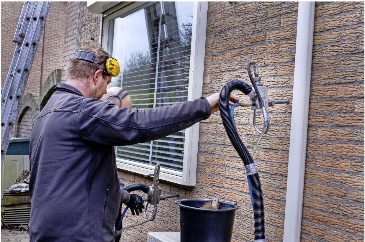
Het aanbrengen spouwmuurisolatie. © C.Barton van Flymen
